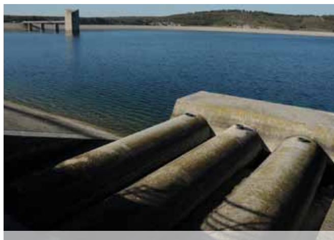
► Au premier plan, le système d'alimentation du réservoir, de type «injecteurs»
